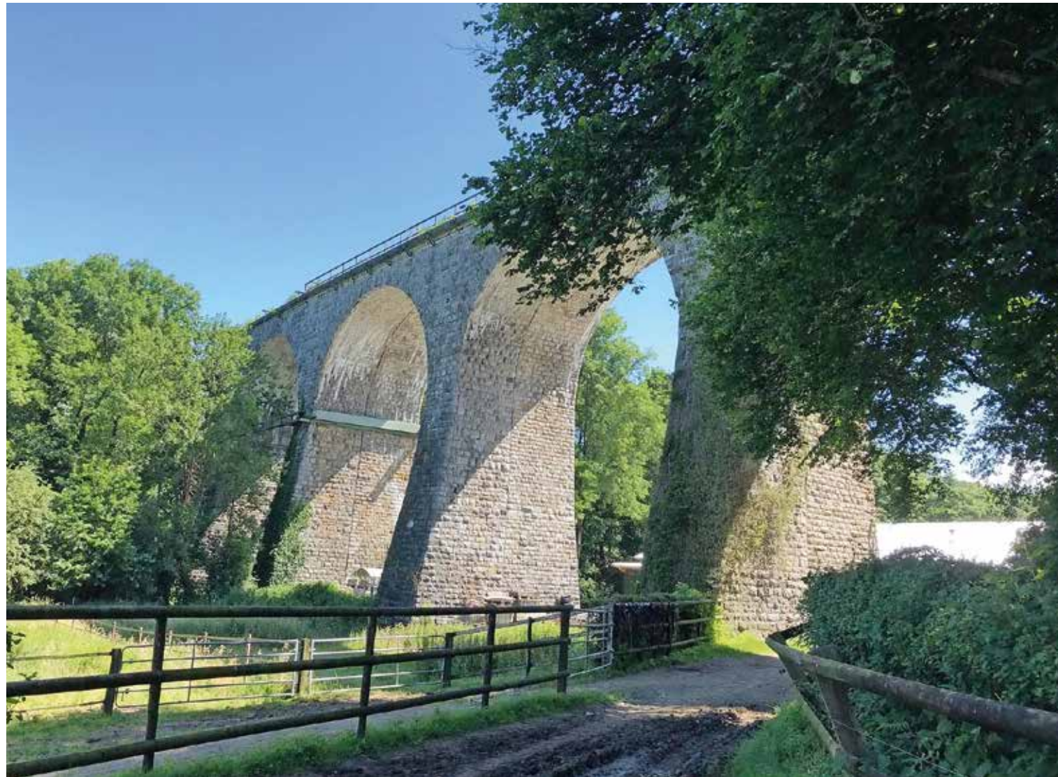
Am Fuß des Itertalviadukts.
