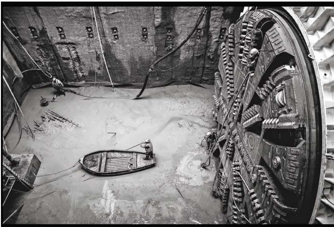
Beim Bau der Wehrhahnlinie in Düsseldorf kam ein riesiger Bohrer zum Einsatz.
